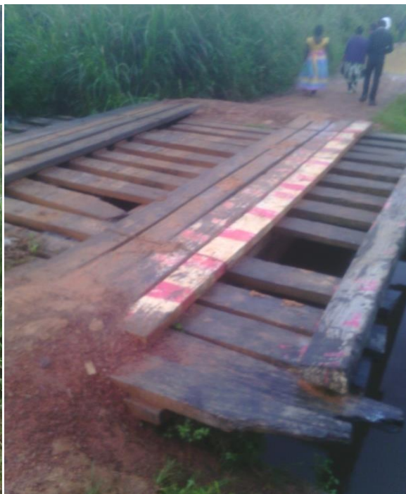
Photo 7: Travaux d'entretien de la route Photo 8 : Ponceau en bois (matériaux provisoires)
